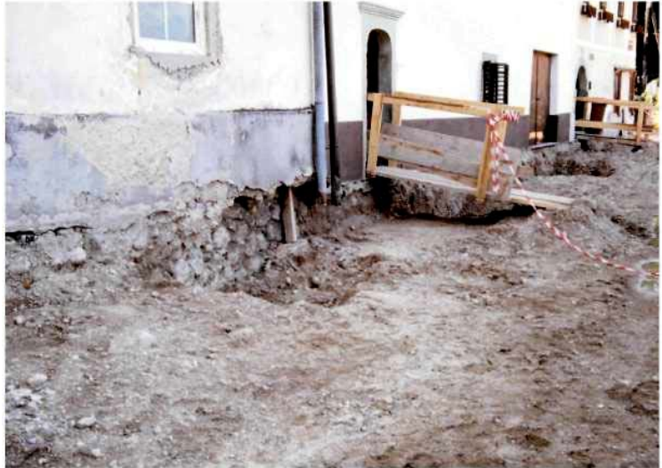
Slika B41. Severni vogal novejšega dela Magušarjeve hiše ob odkopavnih l. 2002.
