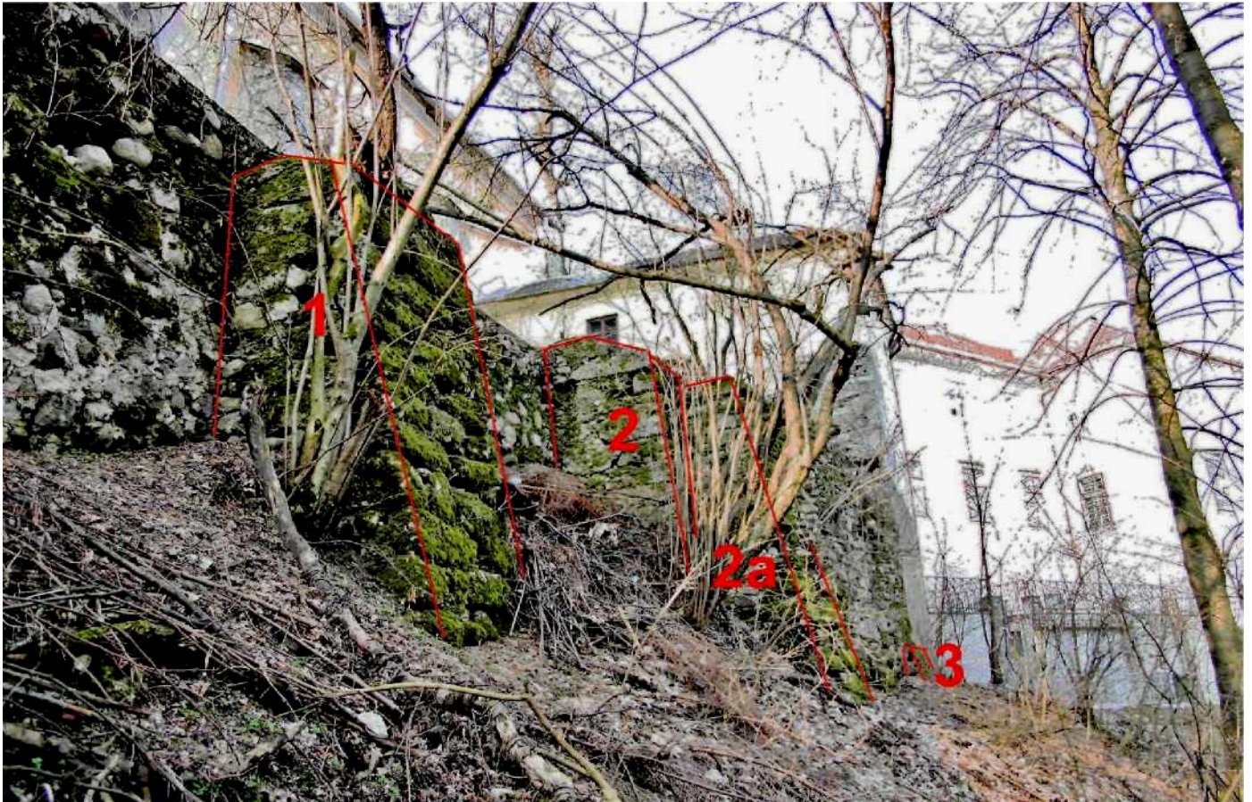
Slika B16. Zazidave med oporniki obrambnega zidu.
