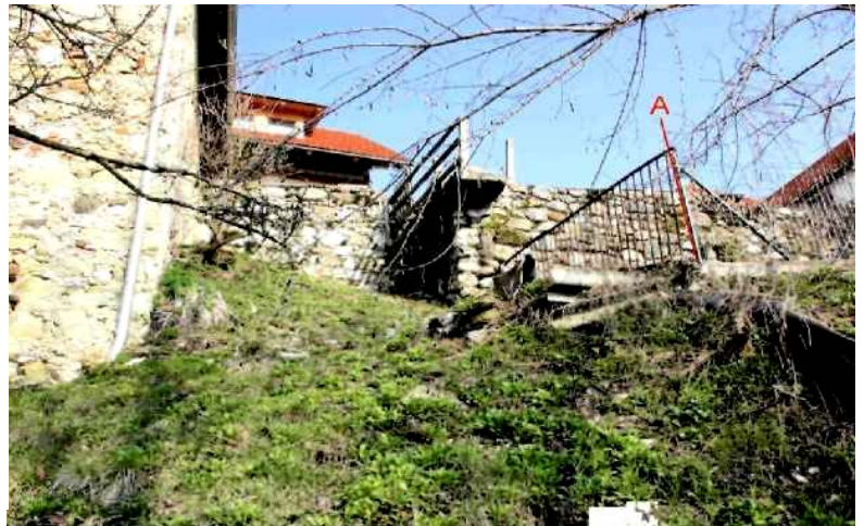
Slika B25. Sklep starih in novejših zidov.
