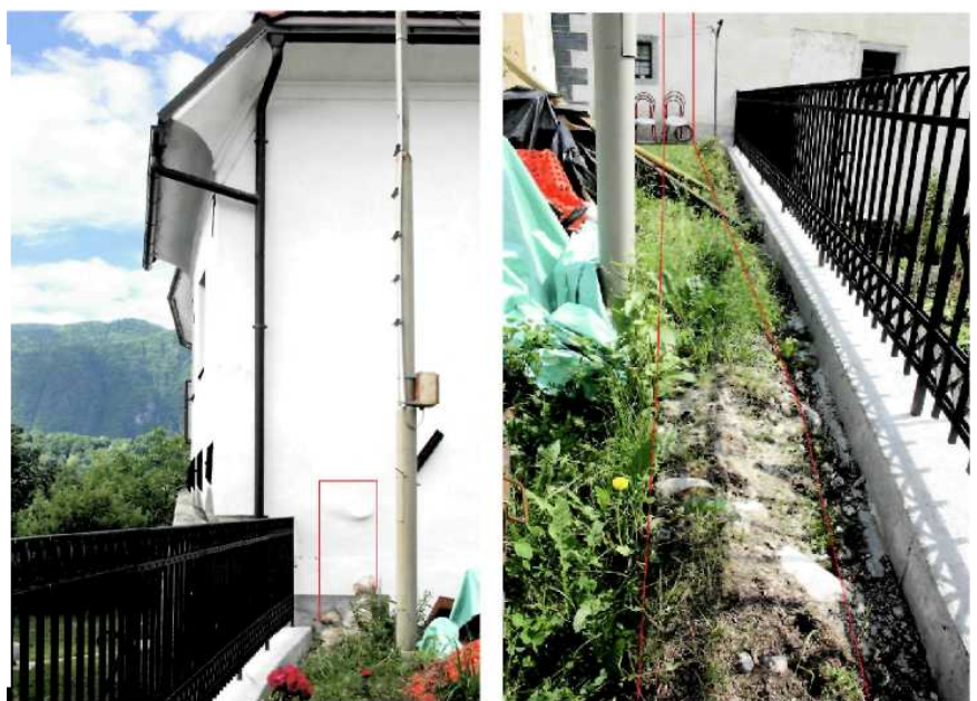
Sliki 24. Ostanki starega zidu med kaplanijo in proštijo.
