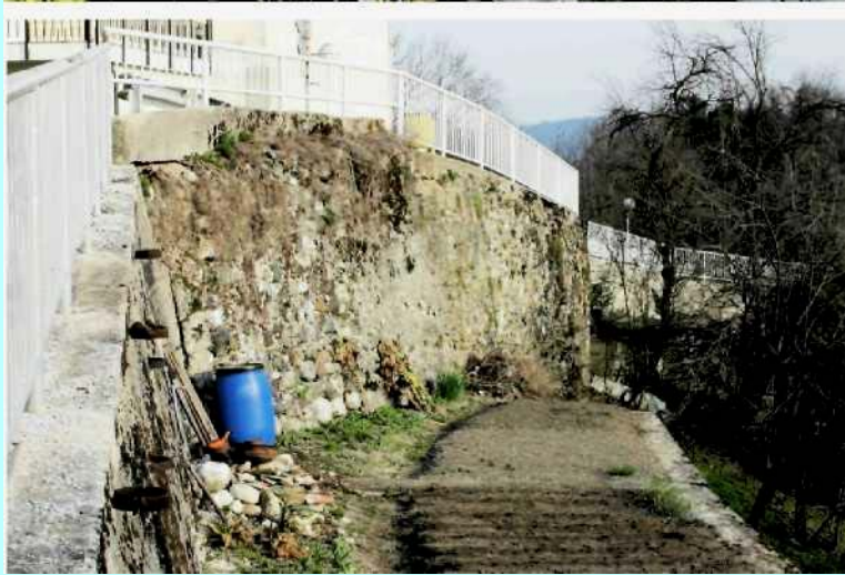
Sliki B28 in B29. Obzidje pod nekdanjo Burcel novo hišo.
