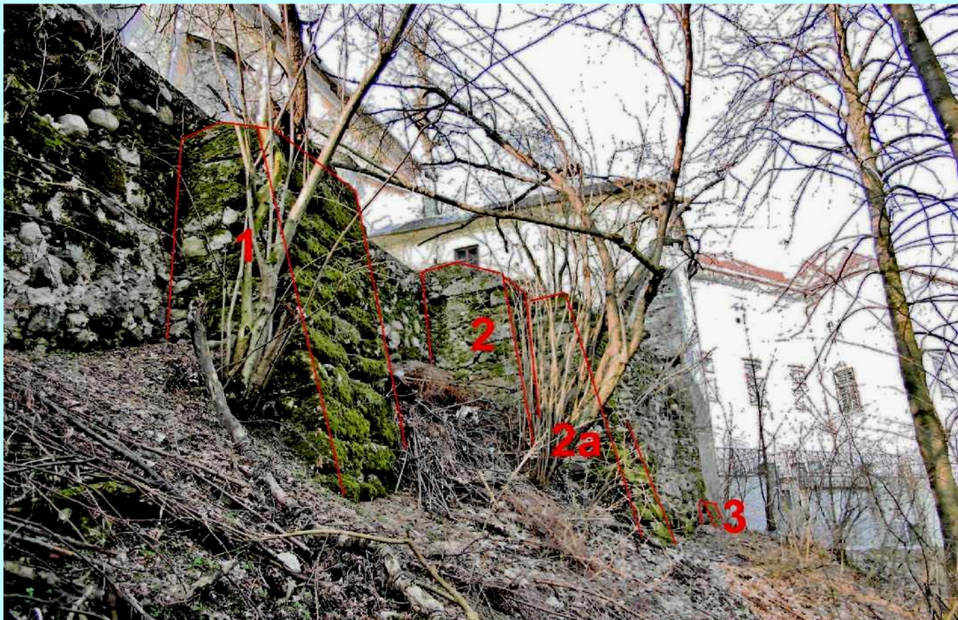
Slika B16. Zazidave med oporniki obrambnega zidu.
