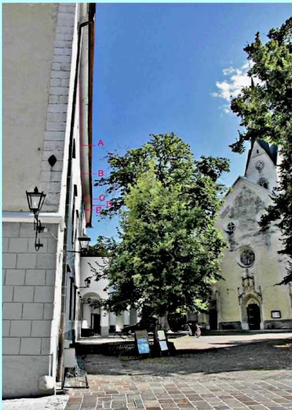
Slika B12. Prelomi v ostrešju vzhodnega dela graščine.
