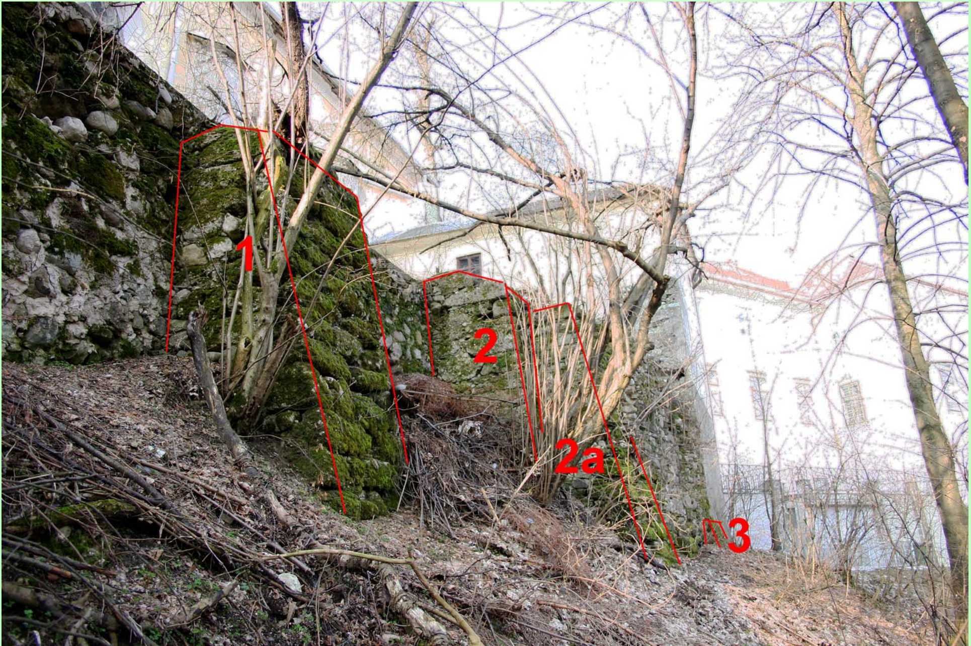
Obrambni zid s svojimi tremi oporniki in dozidanim 2. opornikom.
