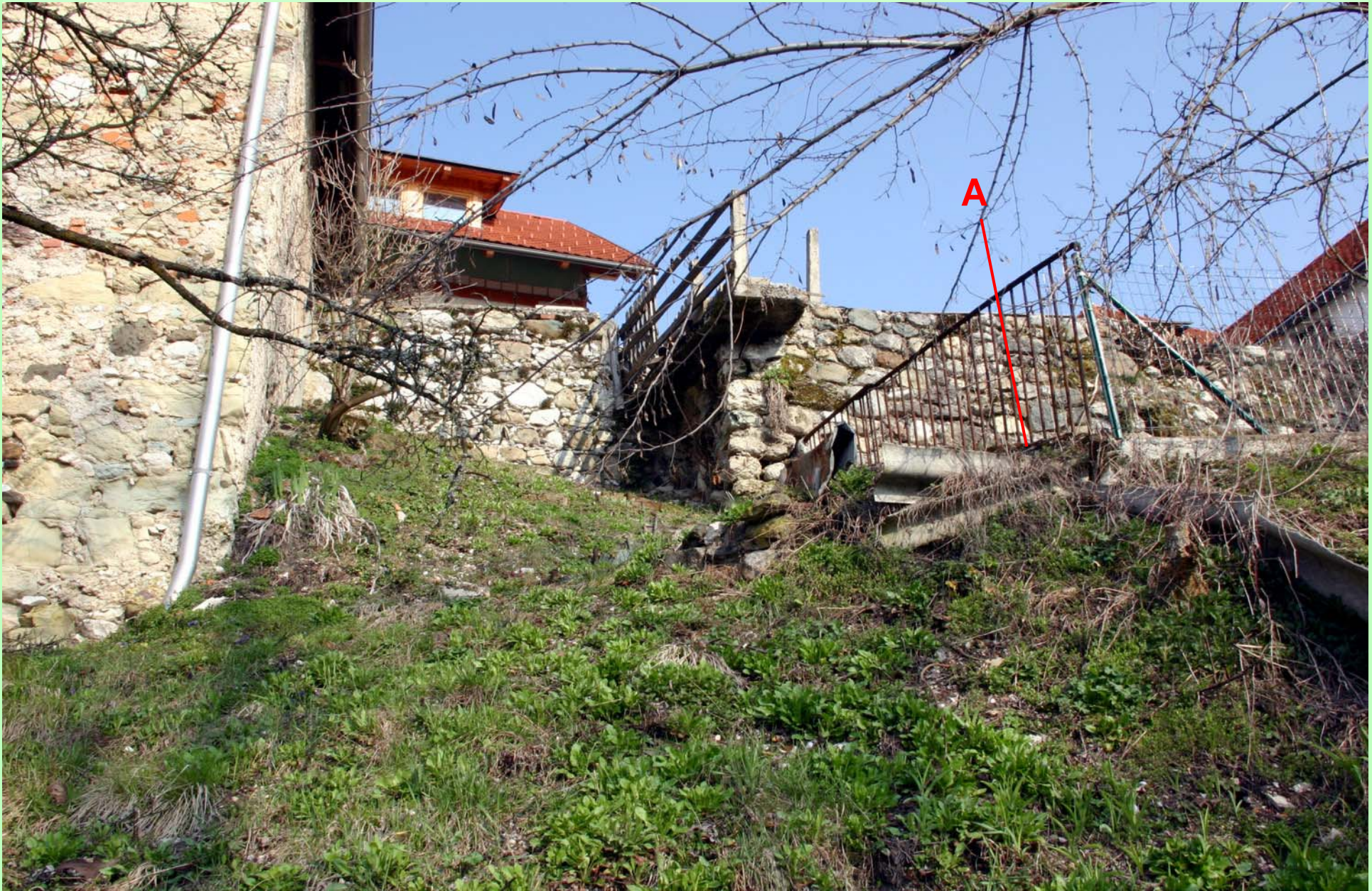
Obnovljeni in dozidani obrambni zid na južnem vogalu župnijskega vrta. Del levo od točke A je bil dozidan po l. 1826 in s tem izravnal župnijski vrt.
