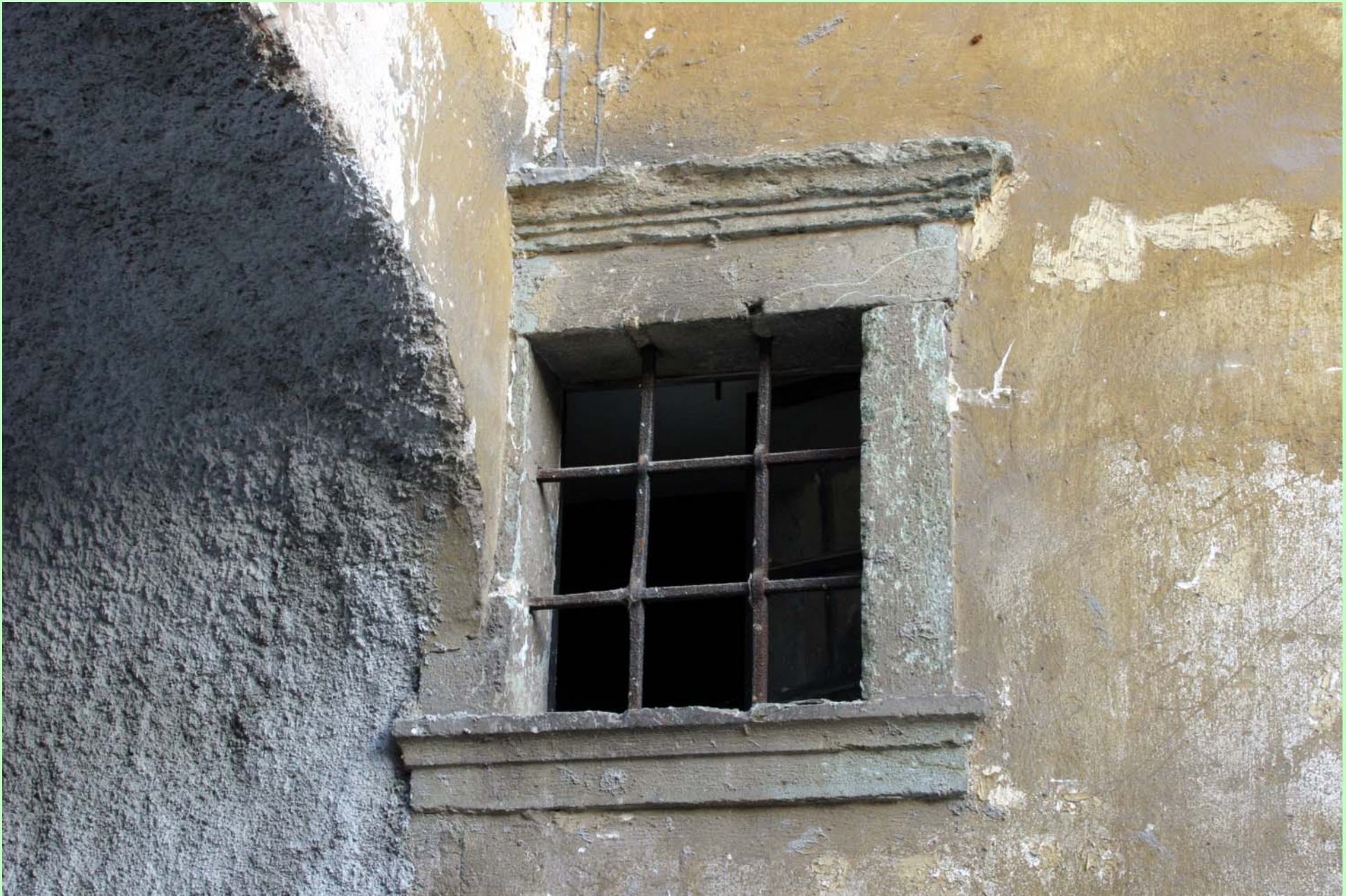
Dodani del podhoda in obzidano okno Dralkine hiše v mestnem jarku.
