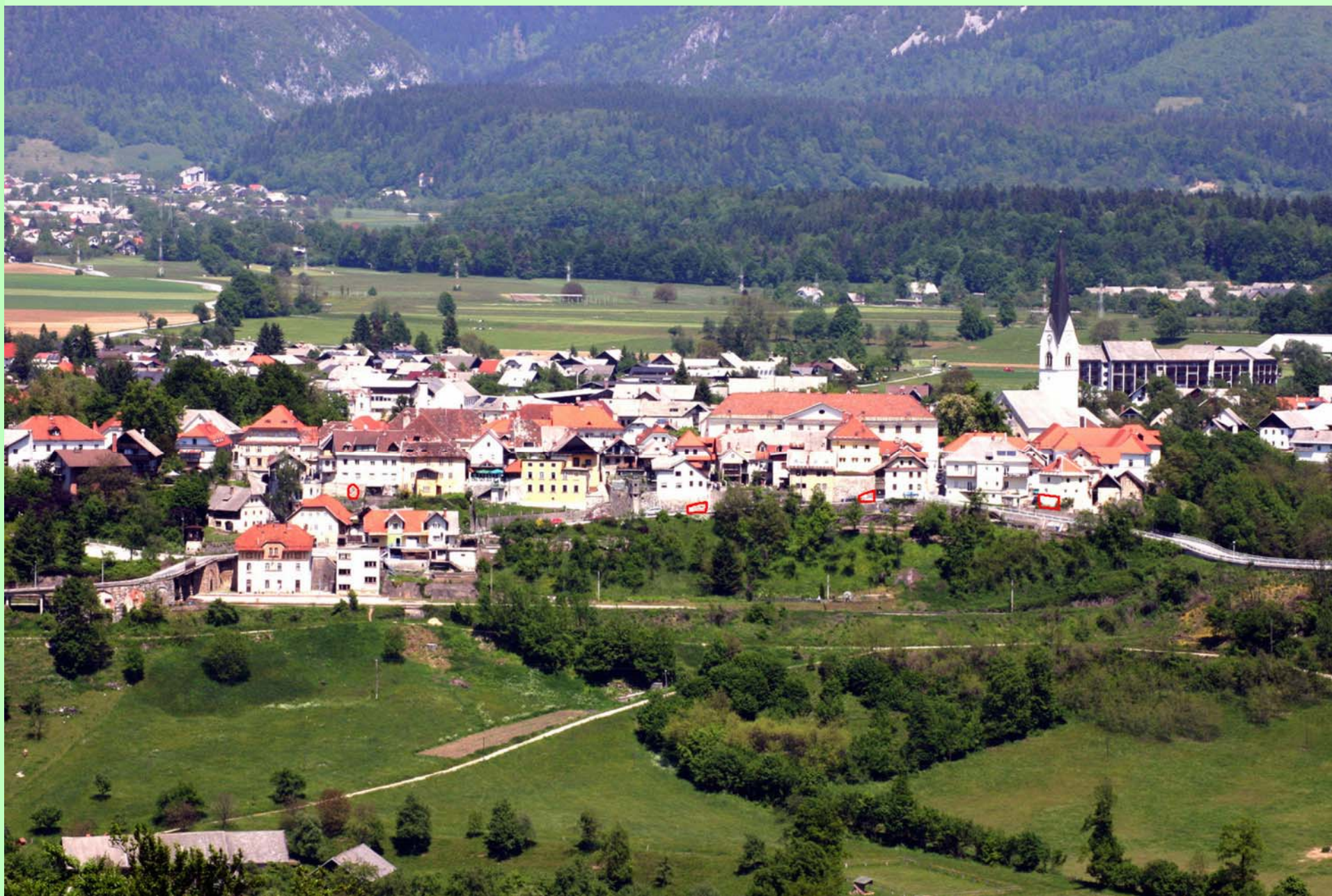
Pogled na Radovljico s Pustega gradu (od Boltarja)
