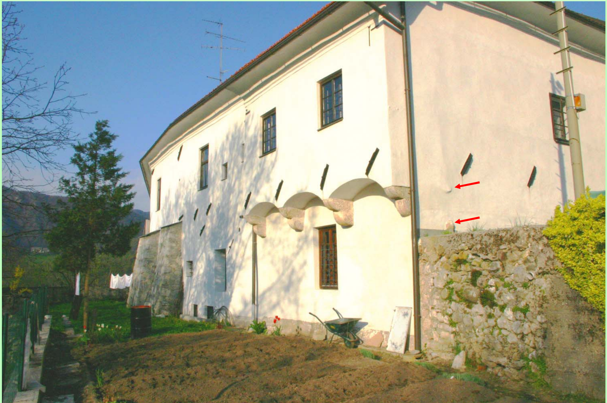
Proštija je zidana na nekdanje obzidje. Najstarejši del (z arkadami) je predstavljal sprva obrambni stolp. Ostanki prvotnega obrambnega zidu so še vidni.
