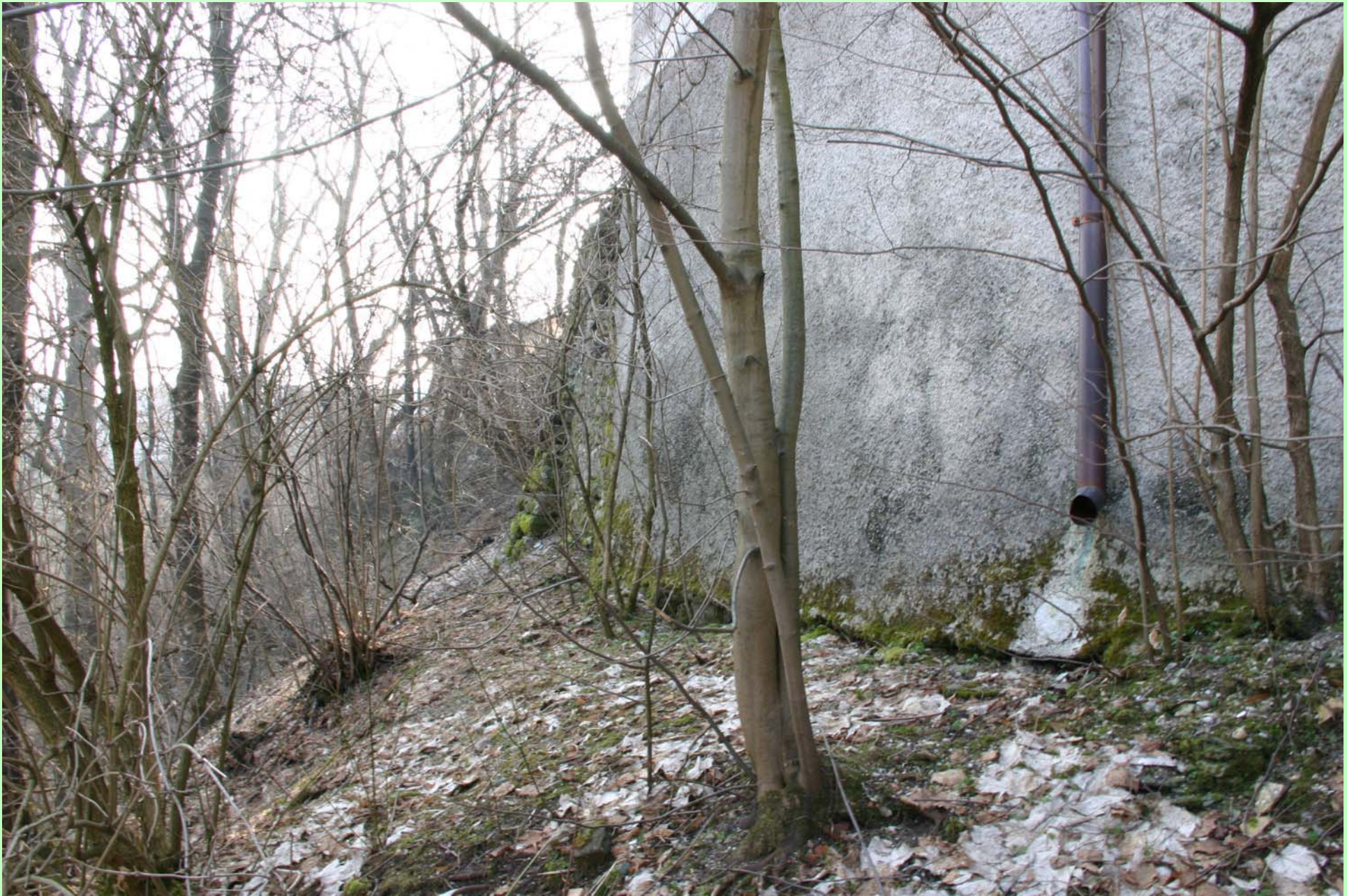
Podporni zid povezovalnega hodnika, v ozadju ostanki starejšega, narejenega pred l. 1761.
