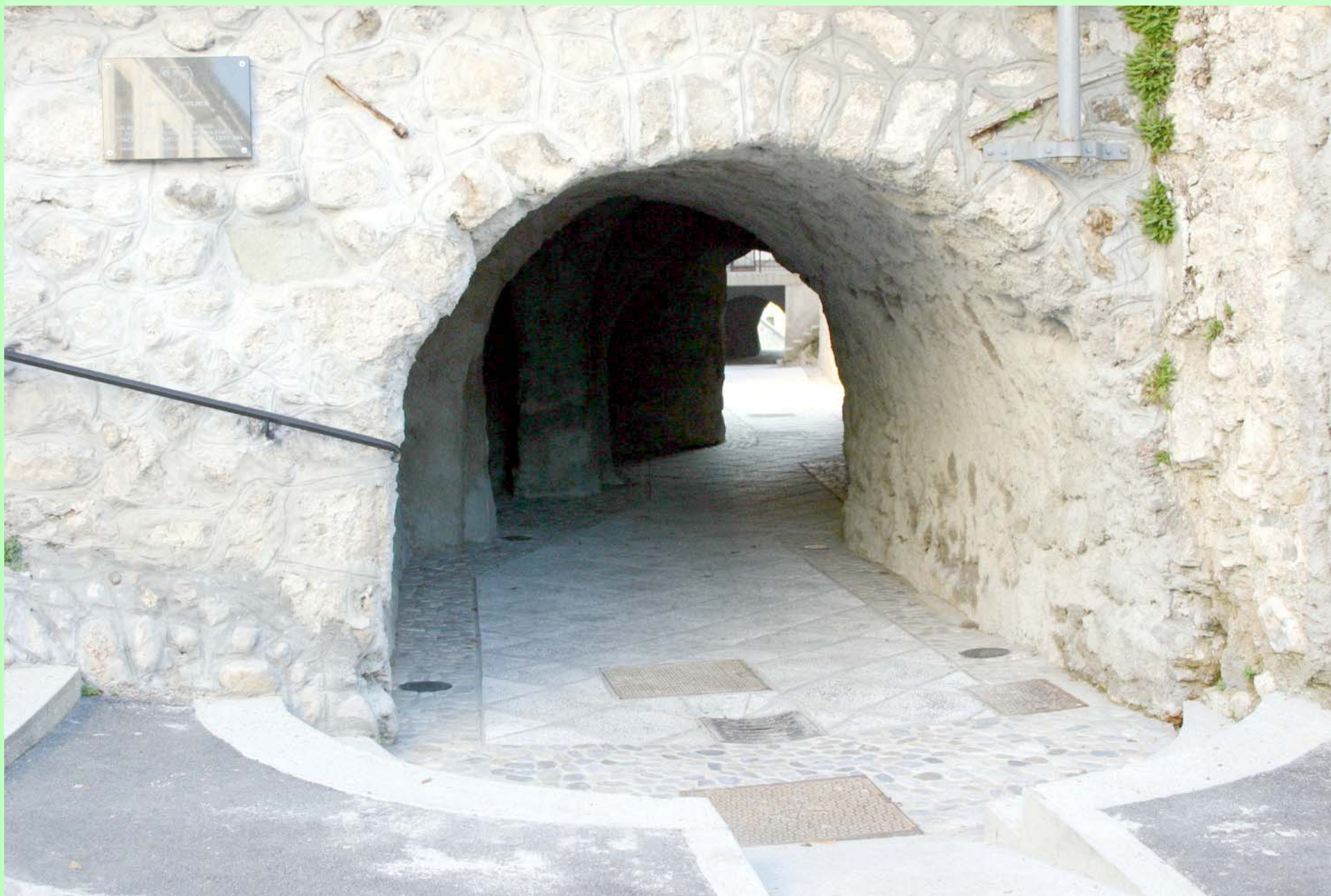
Obnovljeni vhod v nadgrajeni mestni jarek pod Dralkino hišo.
