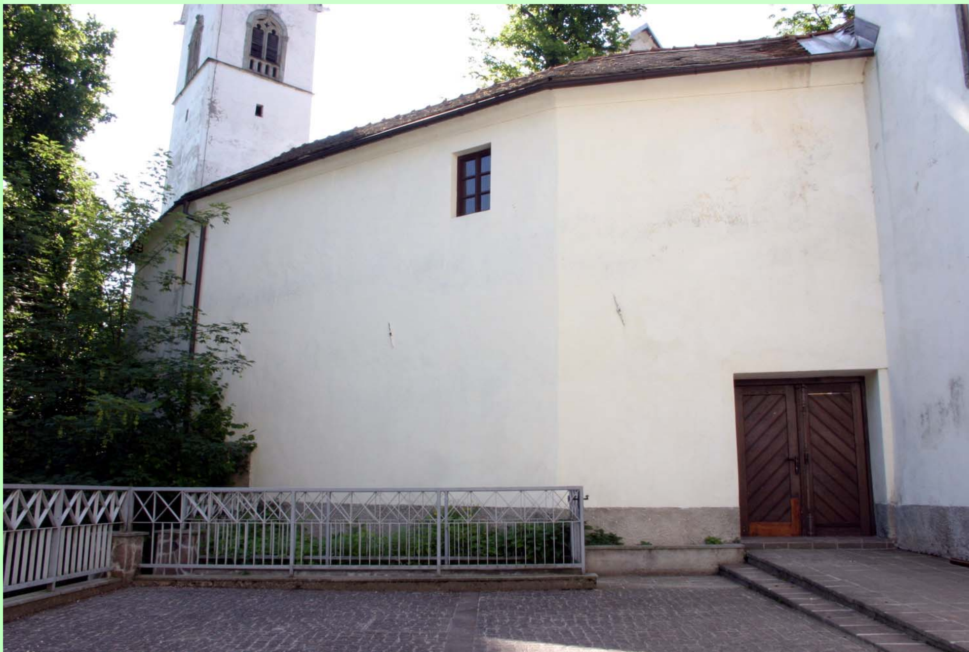
Povezovalni hodnik med graščino in cerkvijo narejen v tej izvedbi po požaru l. 1835.
