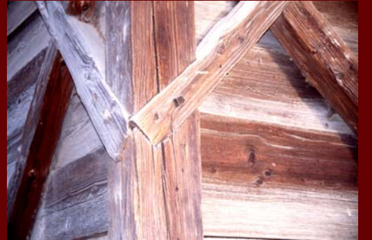
Slika 40. Konstrukcija brunaric – detajl stiki.
