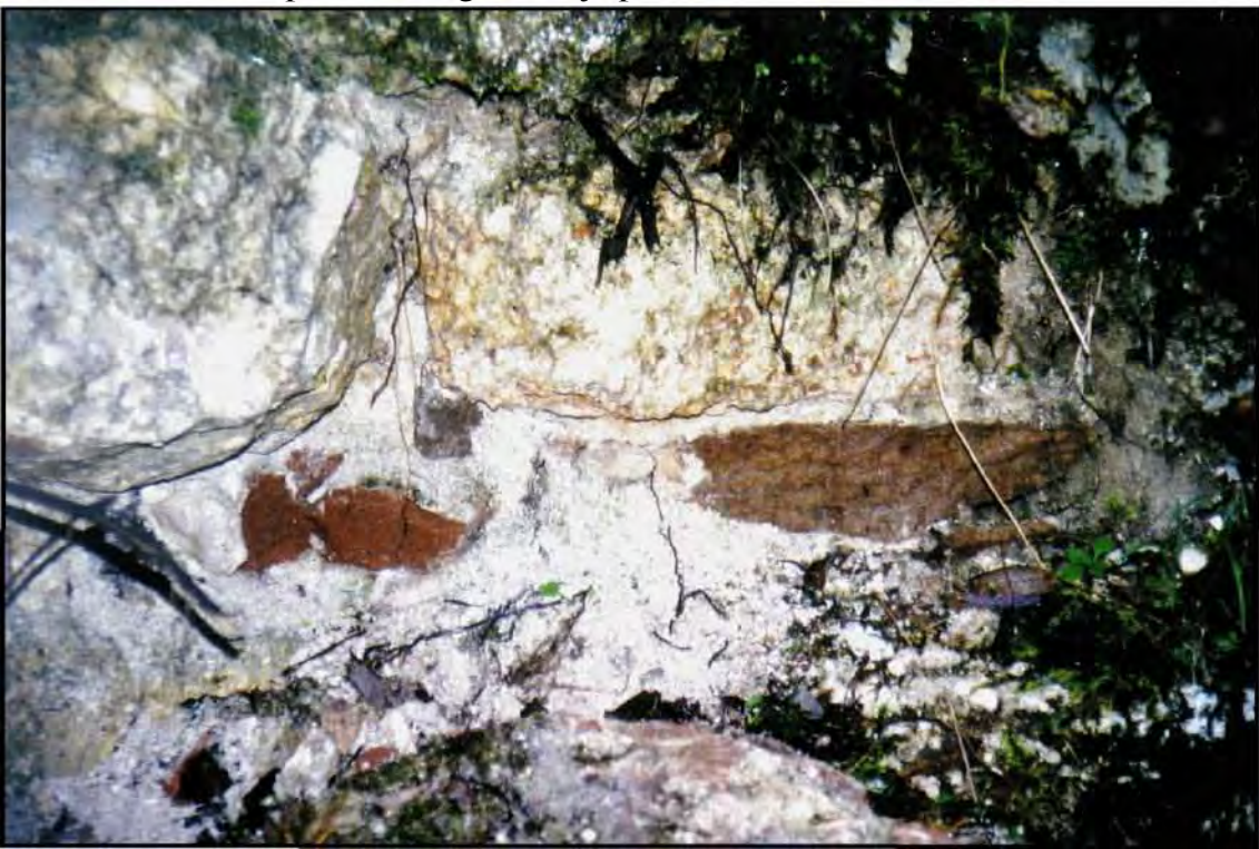
Slika 127. Ostanke pečnih oblog v zidovju plavža na Plavžarici
