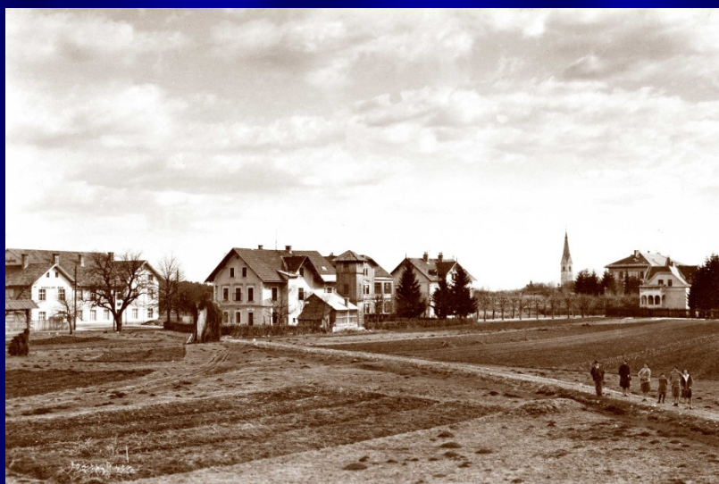
Sokolski dom v času gradnje, ok. 1921. Zasebna zbirka, Radovljica, preslikavi DAR.
