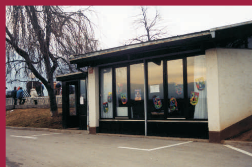
Knjižnica Lesce se je konec šestdesetih let iz prostorov prosvetnega društva v bližini nekdanjega skladišča pohištva Murka preselila v večnamensko stavbo na Alpski cesti št. 58. Foto: Ivan Pipan
